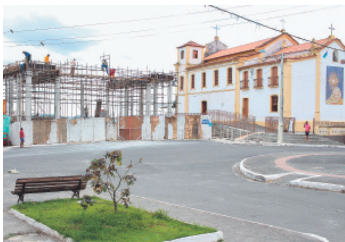
As obras para a construção do palco fixo da Igreja de Nossa Senhora das Candeias estão bem adiantadas
