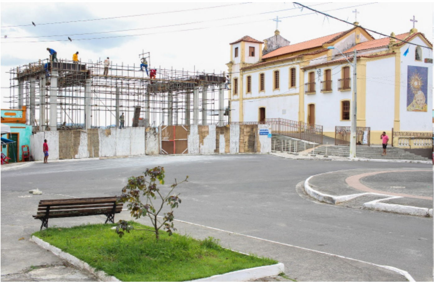
O palco fixo no largo da Igreja de Nossa Senhora das Candeias está sendo construído, graças a uma parceria entre a Prefeitura Municipal, que doou 100 mil reais através de uma Associação e a Igreja. As obras encontram-se em estado adiantado
